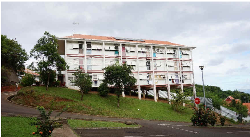
CHE Outumaoro 114 logements et réaménagement de tous les espaces vie (Punaauia)
